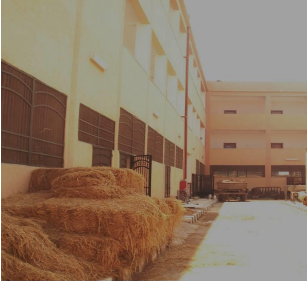
مبنى مزرعة الإنتاج الحيواني
